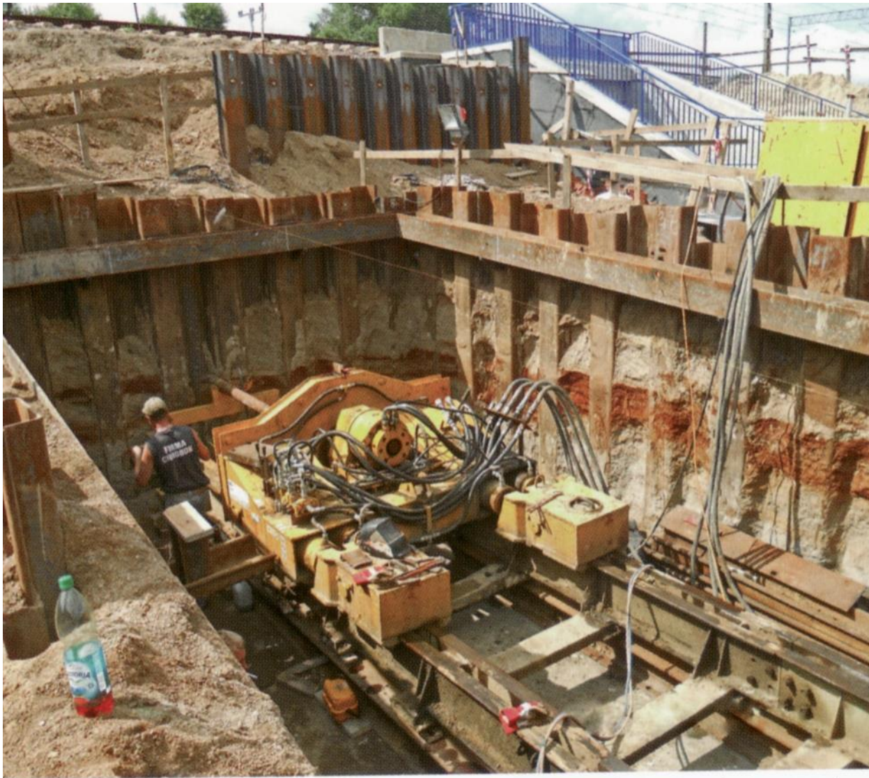
Maszyna WP 80/100 firmy Wamet podczas wykonywania przewiertu żerdzią \phi 114 mm
