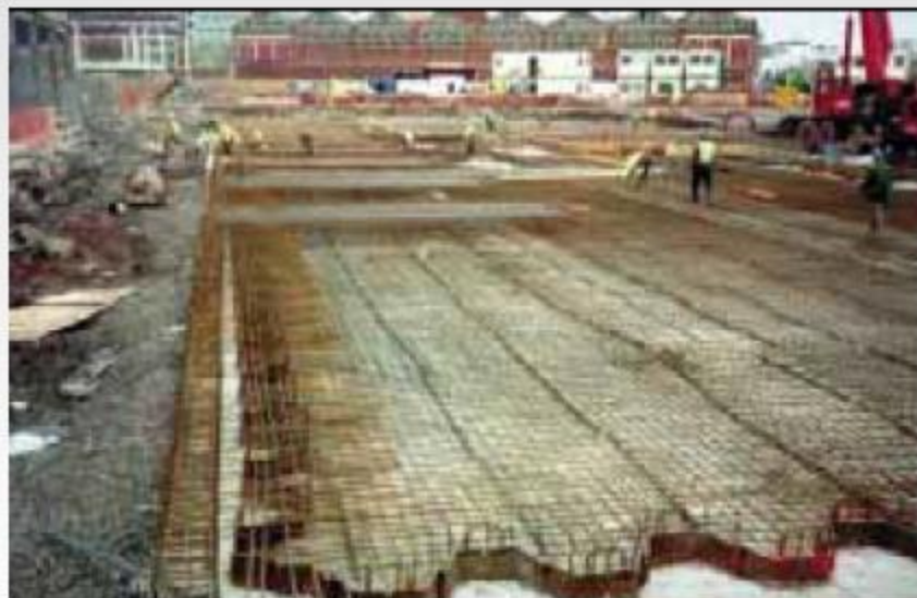
realizacja z zastosowaniem metody stropowej (top-down)
