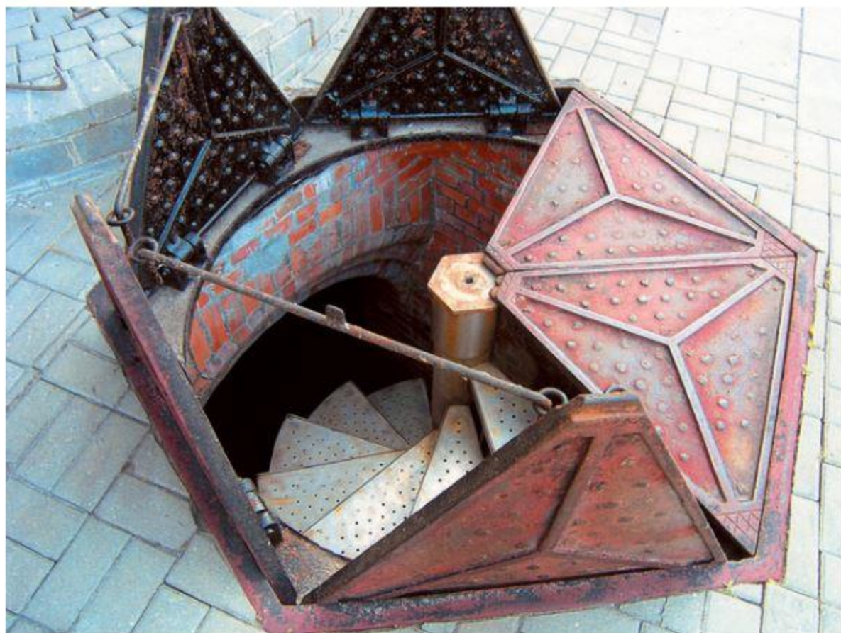
Łódź. "Gwiazda" - nietypowy wjazd do zejścia bocznego, prowadzący do komory łączącej dwa najstarsze łódzkie kolektory i przelew burzowy (foto MPWiK Łódź)
