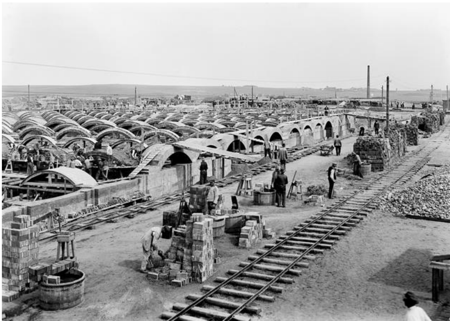
Budowa zbiorników wody w Łodzi. 1935-1937 r. Zaprojektował je na początku XX wieku William Heerlein Lindley. W jednym z wyższych miejsc miasta - 260 m n.p.m. - powstały rezerwuary wody pełniące rolę gigantycznej wieży ciśnień. Zostały zbudowane na planie czterech kwadratów o boku 60 m każdy, ze specjalnie wypalanej cegły, ze ścianami w kształcie łuków, by zmniejszyć ciśnienie zgromadzonej w nich wody. Rozbudowane po II wojnie światowej łódzkie zbiorniki mieszczą 100 tys. m 3 wody (arch. ZWiK Łódź)
