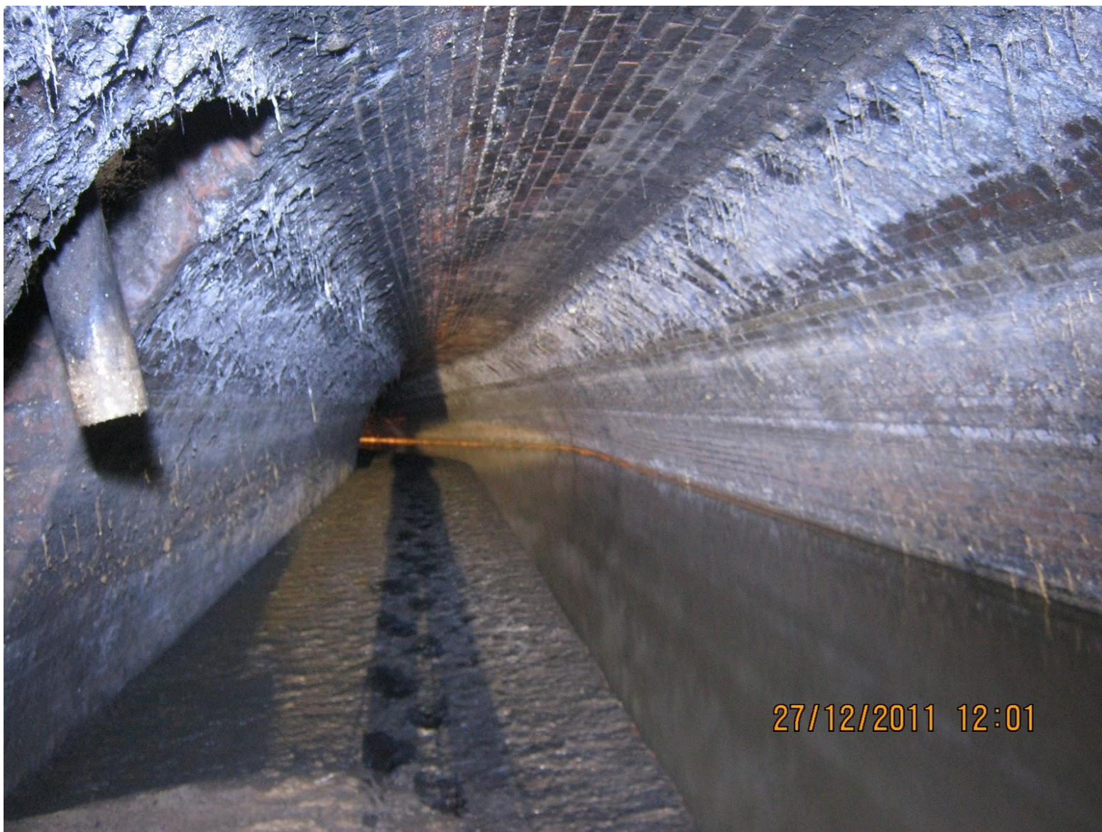
Nowy Kolektor Południowy 2,9 x 3,9 m
