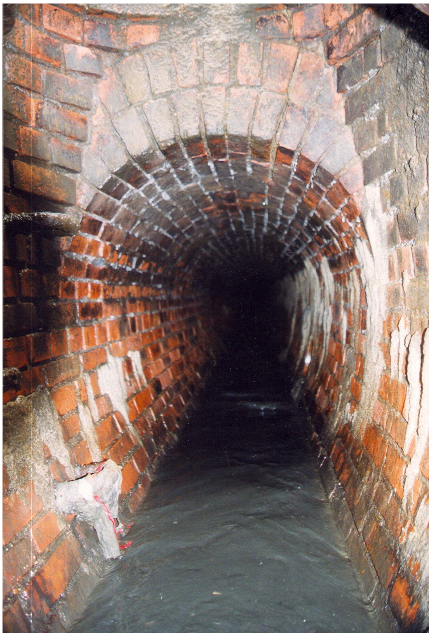
Kolektor ceglany pod ulicą Nowy Świat we Wrocławiu (1150 X 1300 mm)
