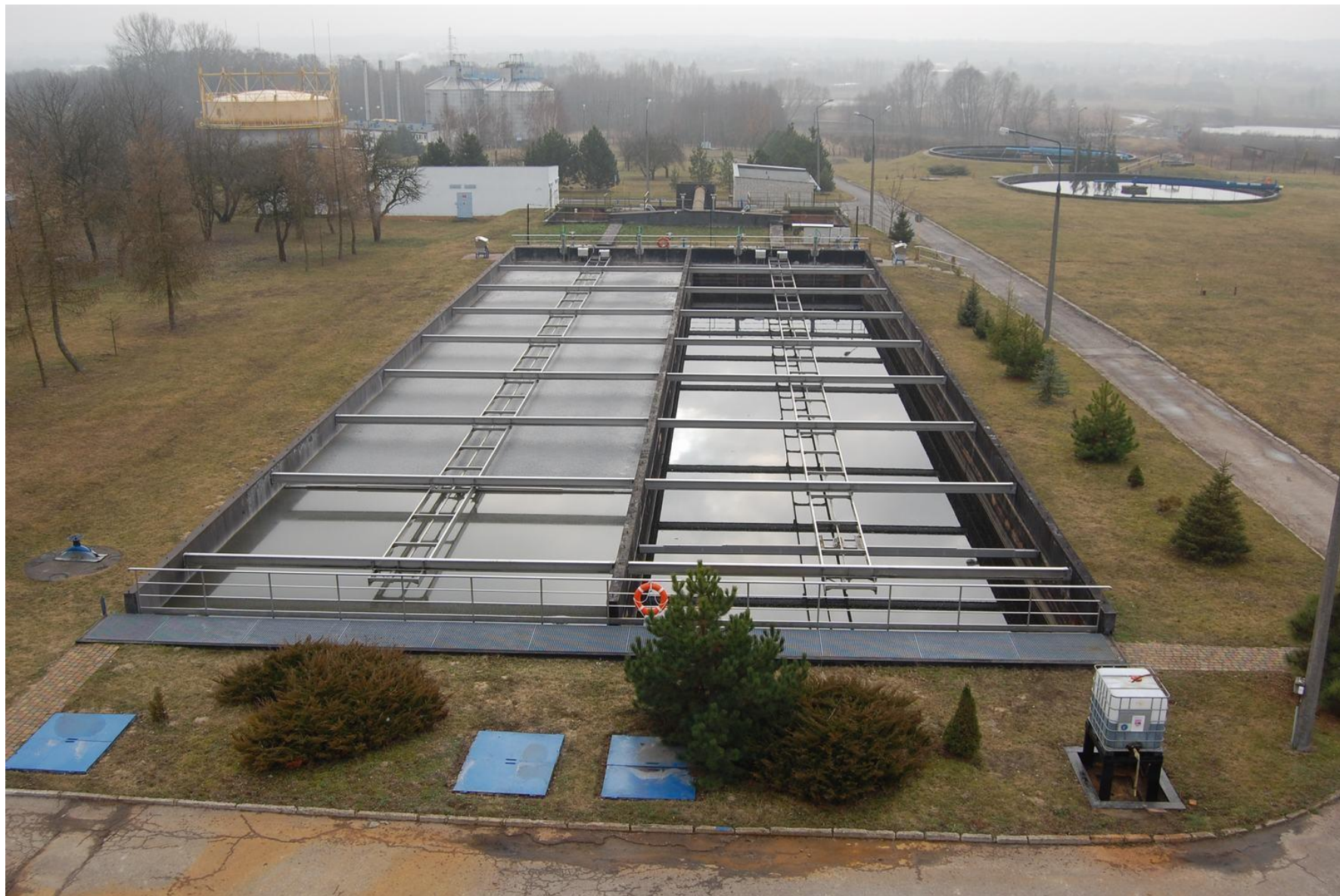
Osadnik prostokątny wstępny ze zgarniaczem dennym zgrzeblowym i powierzchniowym ( http://kpwik.krasnik.pl/osadniki-wstepne )
