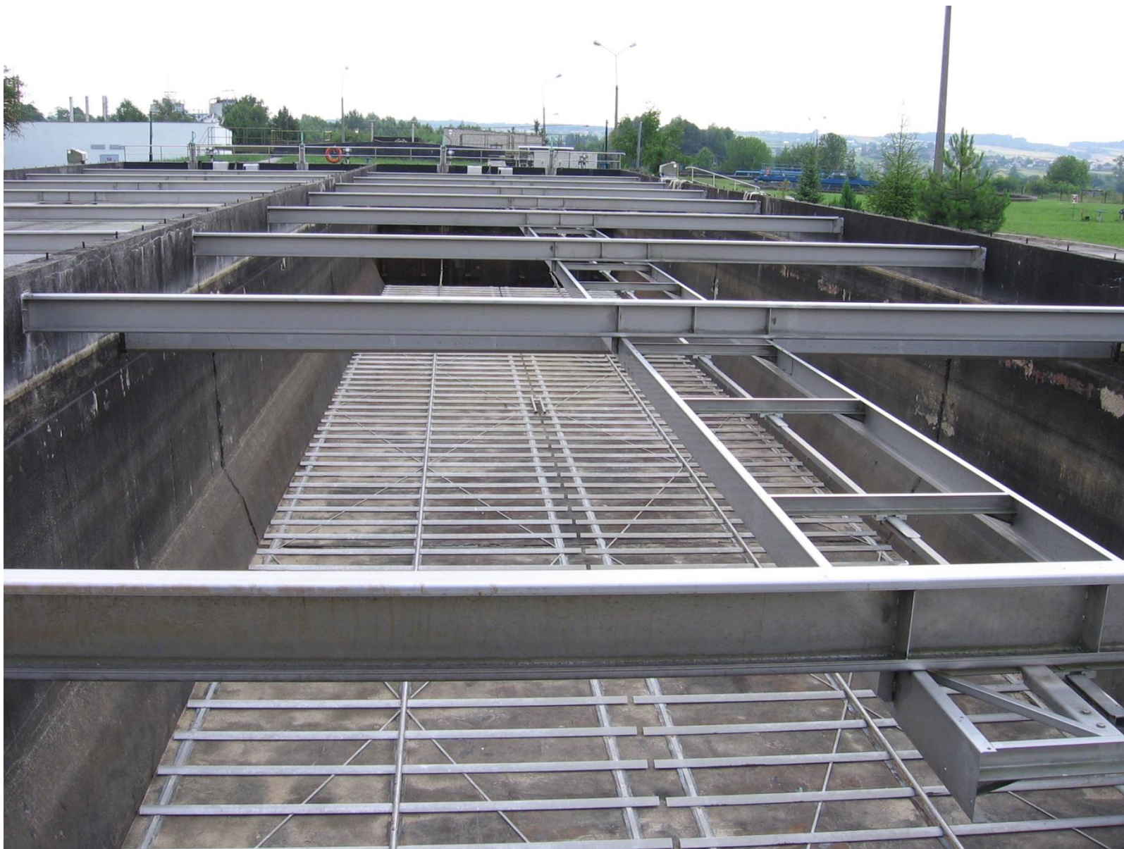
Osadnik prostokątny wstępny ze zgarniaczem dennym zgrzeblowym i powierzchniowym ( http://kpwik.krasnik.pl/osadniki-wstepne )
