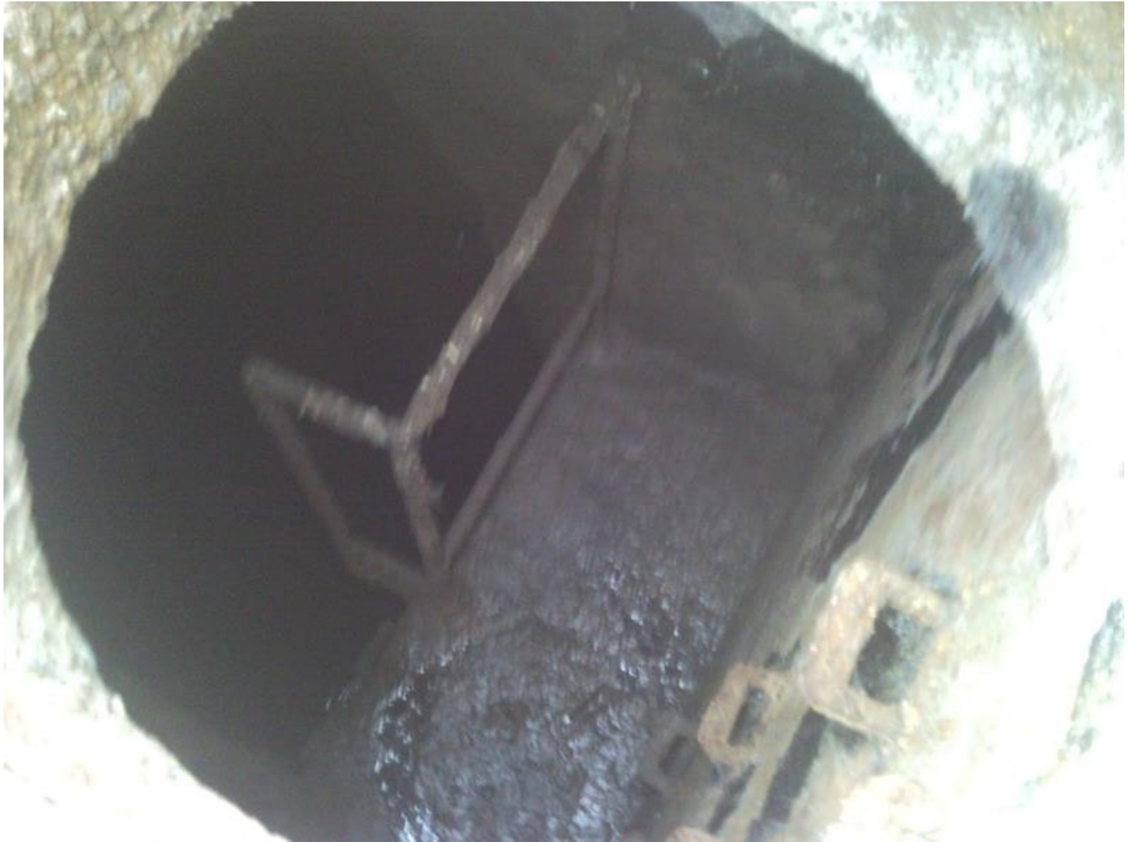
komora na kolektorze Odra we Wrocławiu
