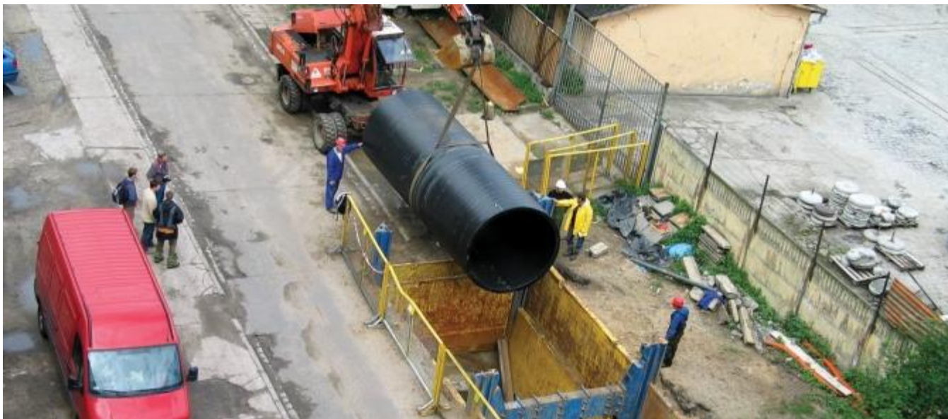
wprowadzane do uszkodzonego rurociągu tworzywowe panele renowacyjne
