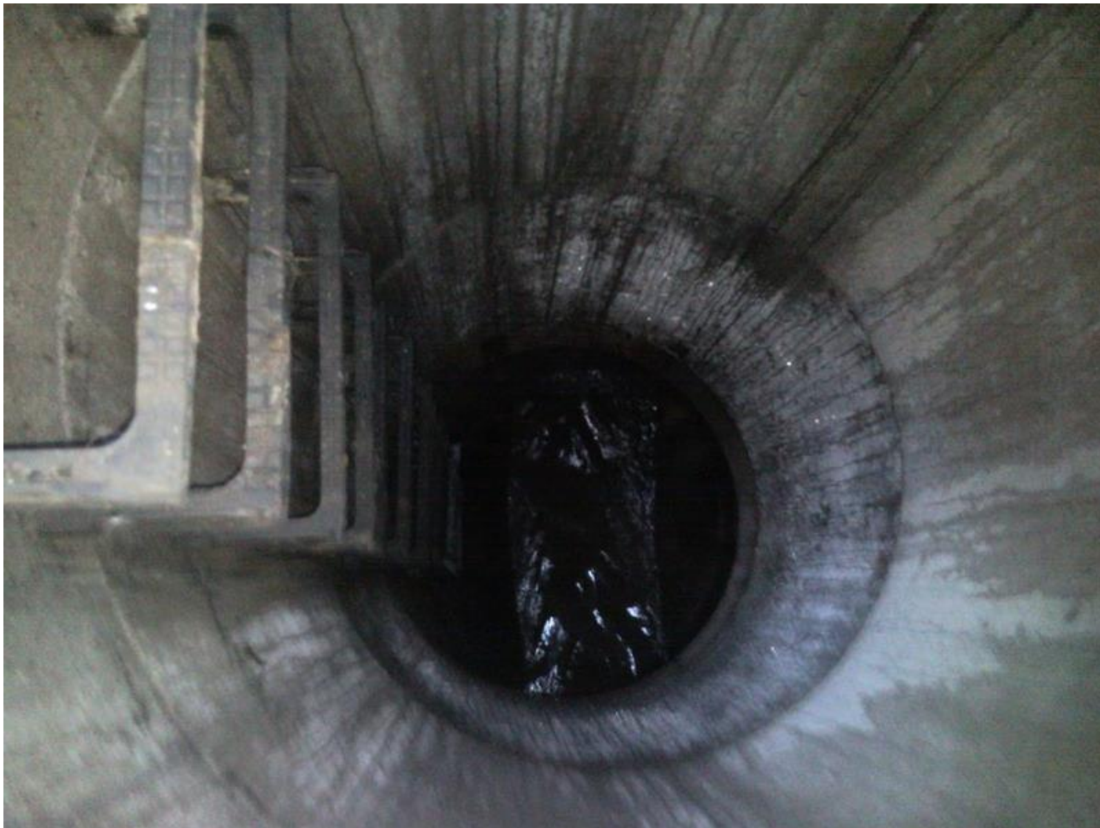
kolektor Ślęza – komin złazowy do komory
