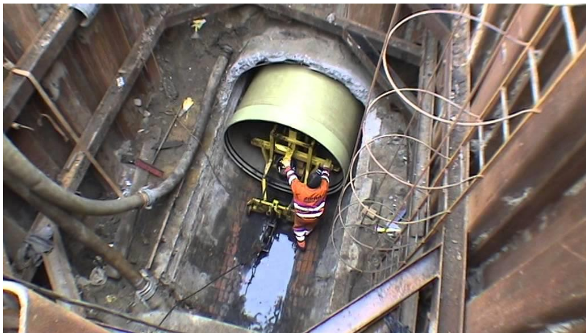
wprowadzane do uszkodzonego rurociągu tworzywowe panele renowacyjne
