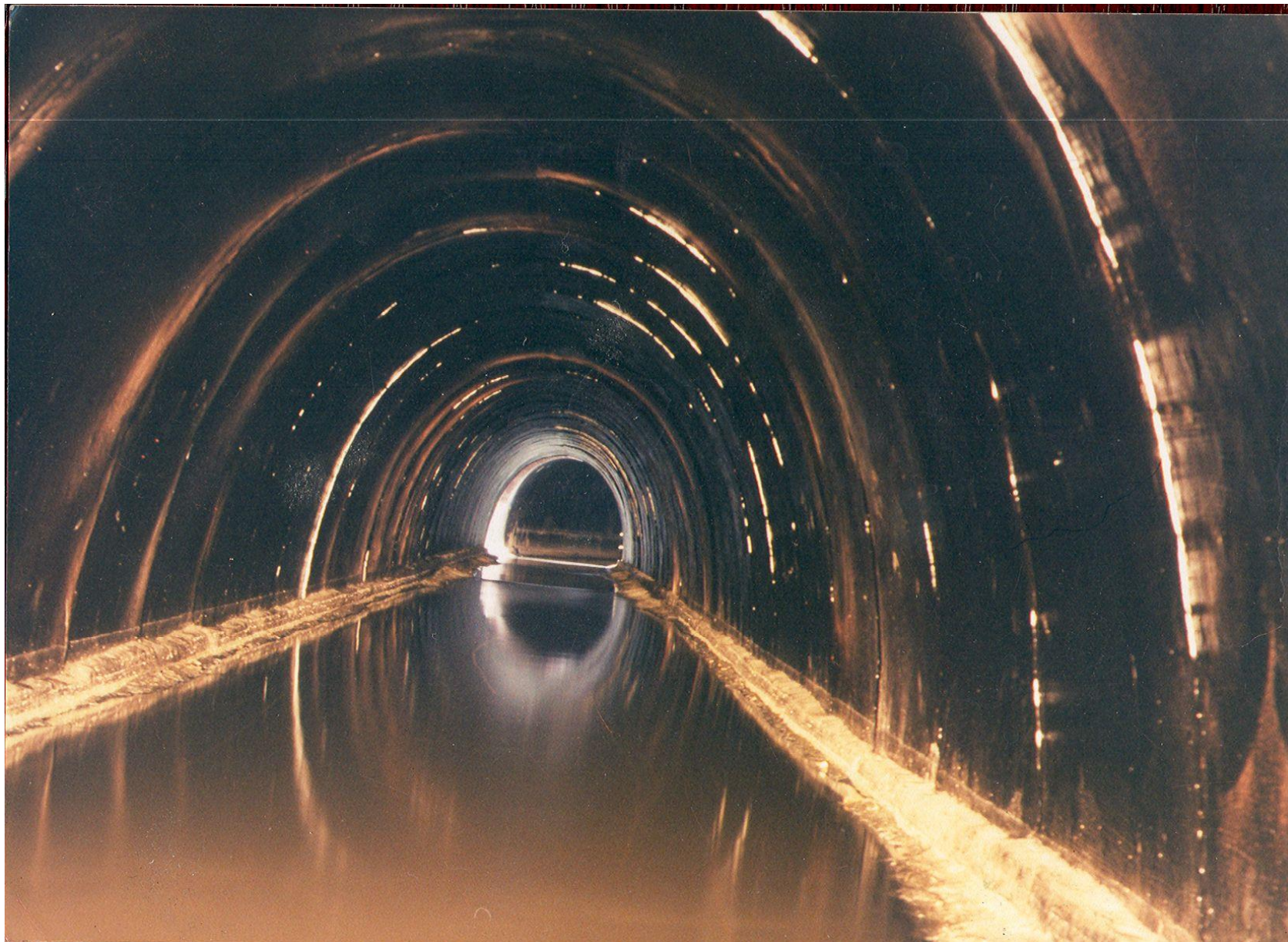
Kolektor żelbetowy „Odra” we Wrocławiu ( h = 2,92 m, w = 3,50 m) (lata 70. – 90.)
