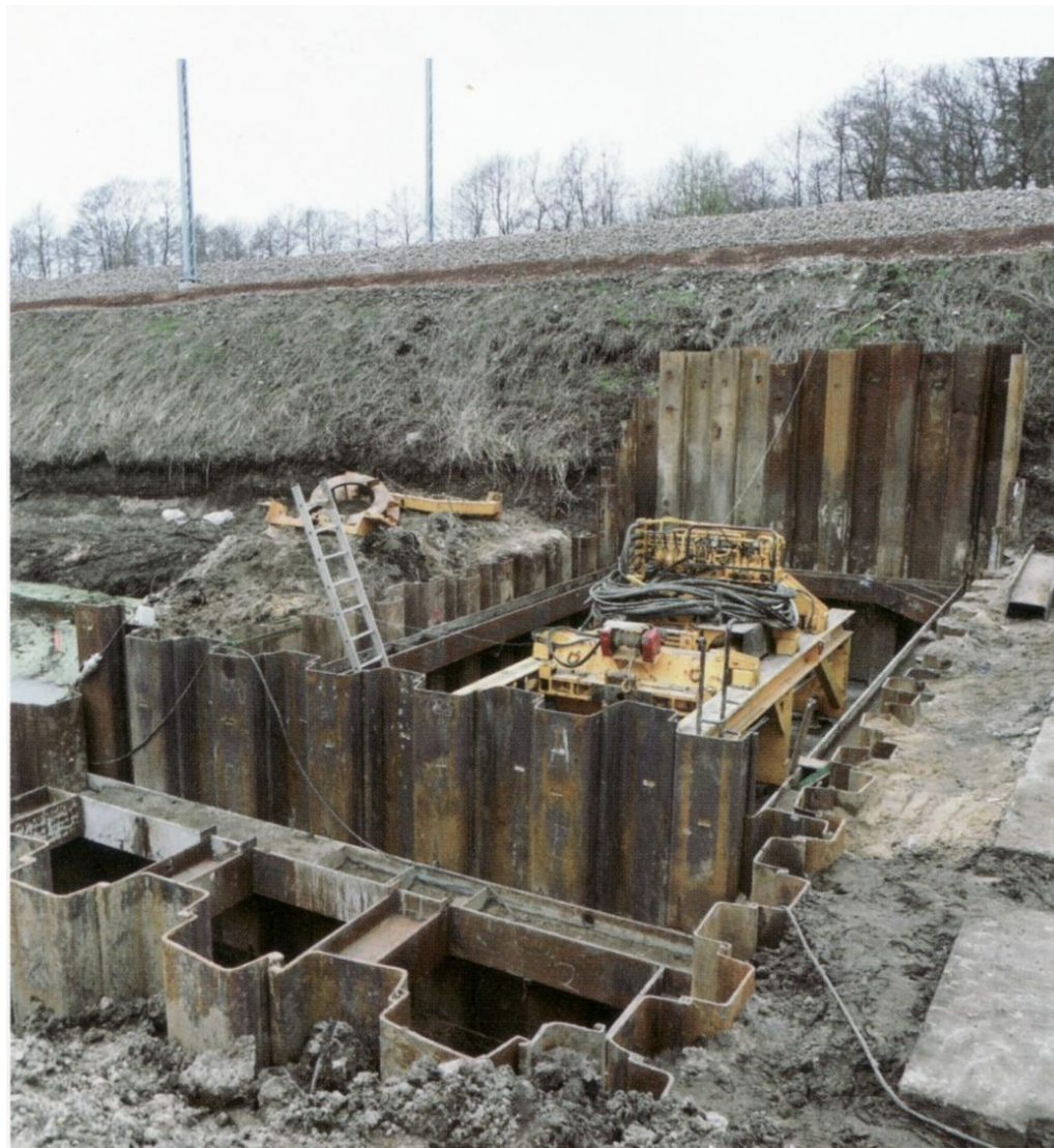
Realizacja przepustu pod torami (komora nadawcza)
