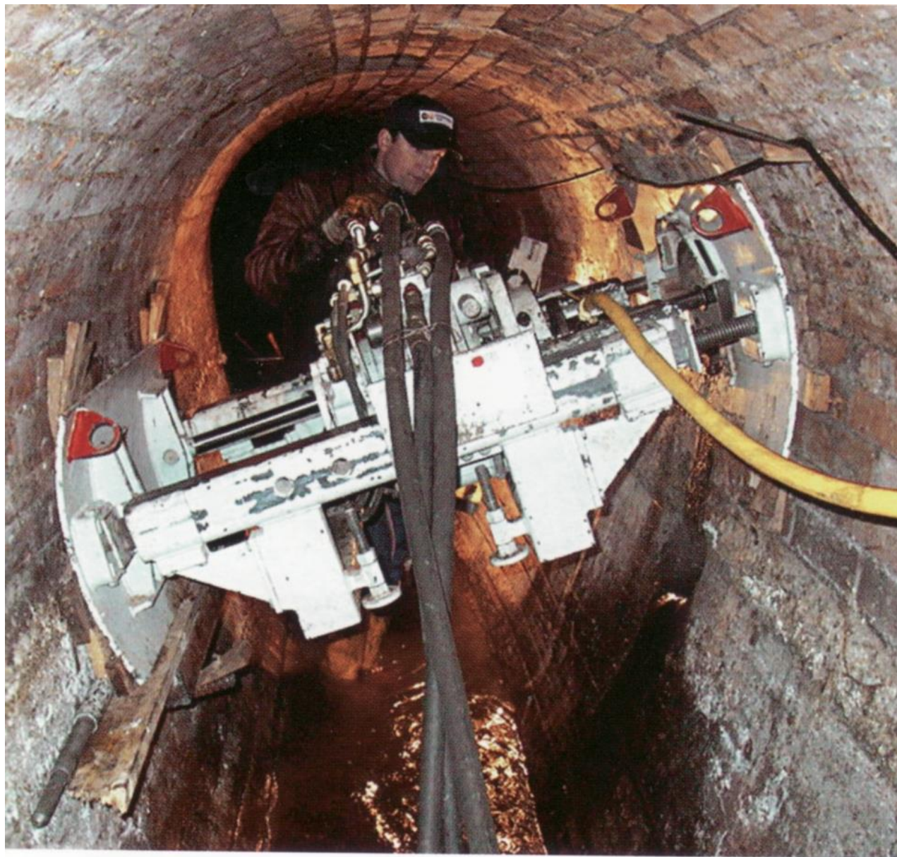
Budowa przykanalika z kolektora murowanego o przekroju jajowym
