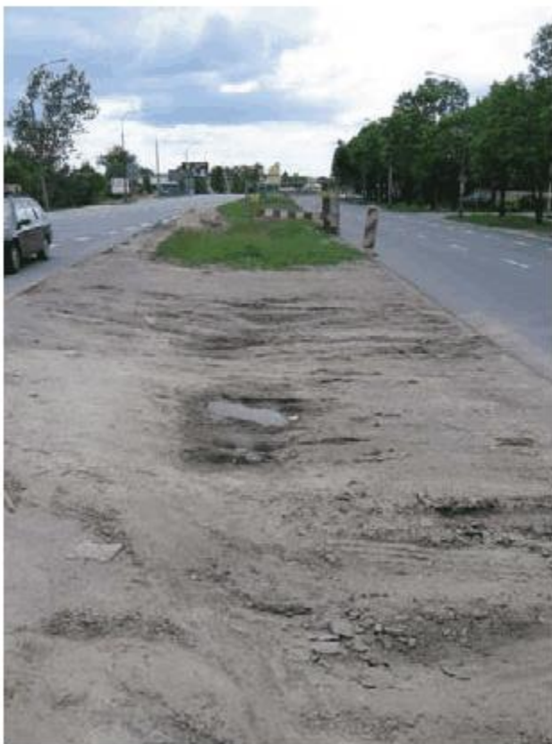
Zapadnięta powierzchnia terenu wzdłuż osi kanału za komorą startową (z lewej). Zniszczona trawa w niecce nad kanałem (z prawej)
