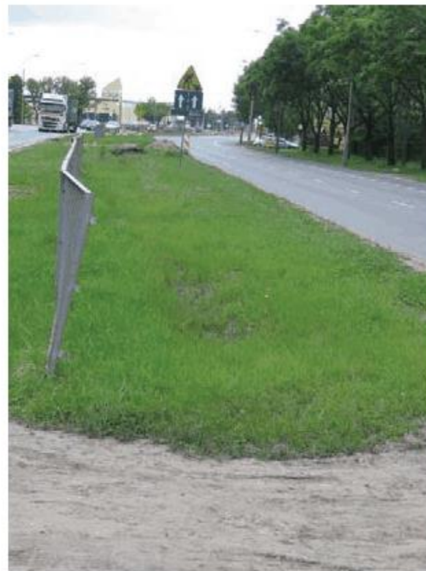
Zapadnięta powierzchnia terenu wzdłuż osi kanału za komorą startową (z lewej). Zniszczona trawa w niecce nad kanałem (z prawej)
