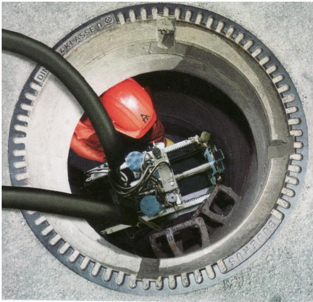
Budowa przykanalika w technologii przewiertu sterowanego ze studzienki kanalizacyjnej [8]
