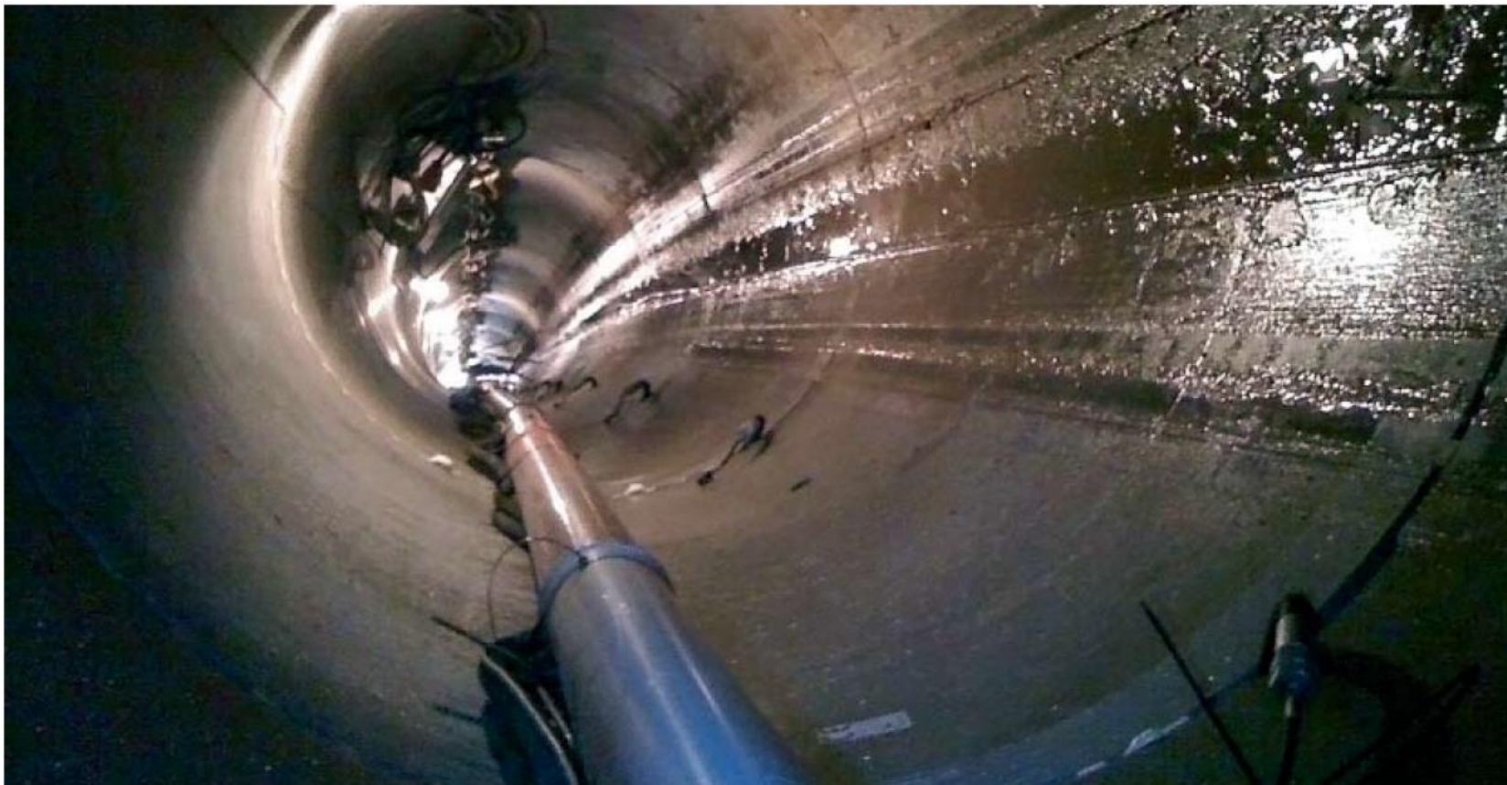
Wbudowany rurociąg z zastosowaniem złączy hydraulicznych [1]
