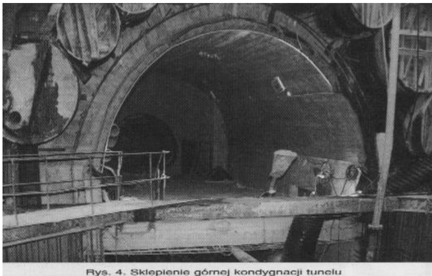
Rys. 4. Sklepienie górnej kondygnacji tunelu
