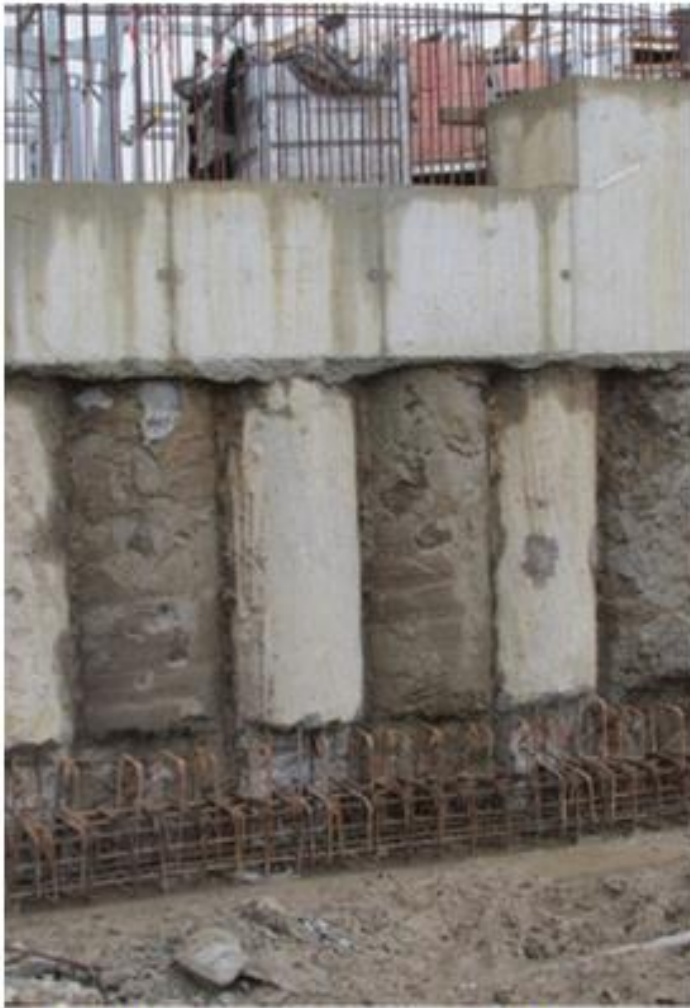
Fot. 6 Przykład palisady wykonanej z różnych elementów - pierwotne to kolumny DSM, a wtórne to pale CFA zbrojone / Fot. 7 Palisada z pali rozsuniętych, przestrzeń między palami wypełniona opinką drewnianą
