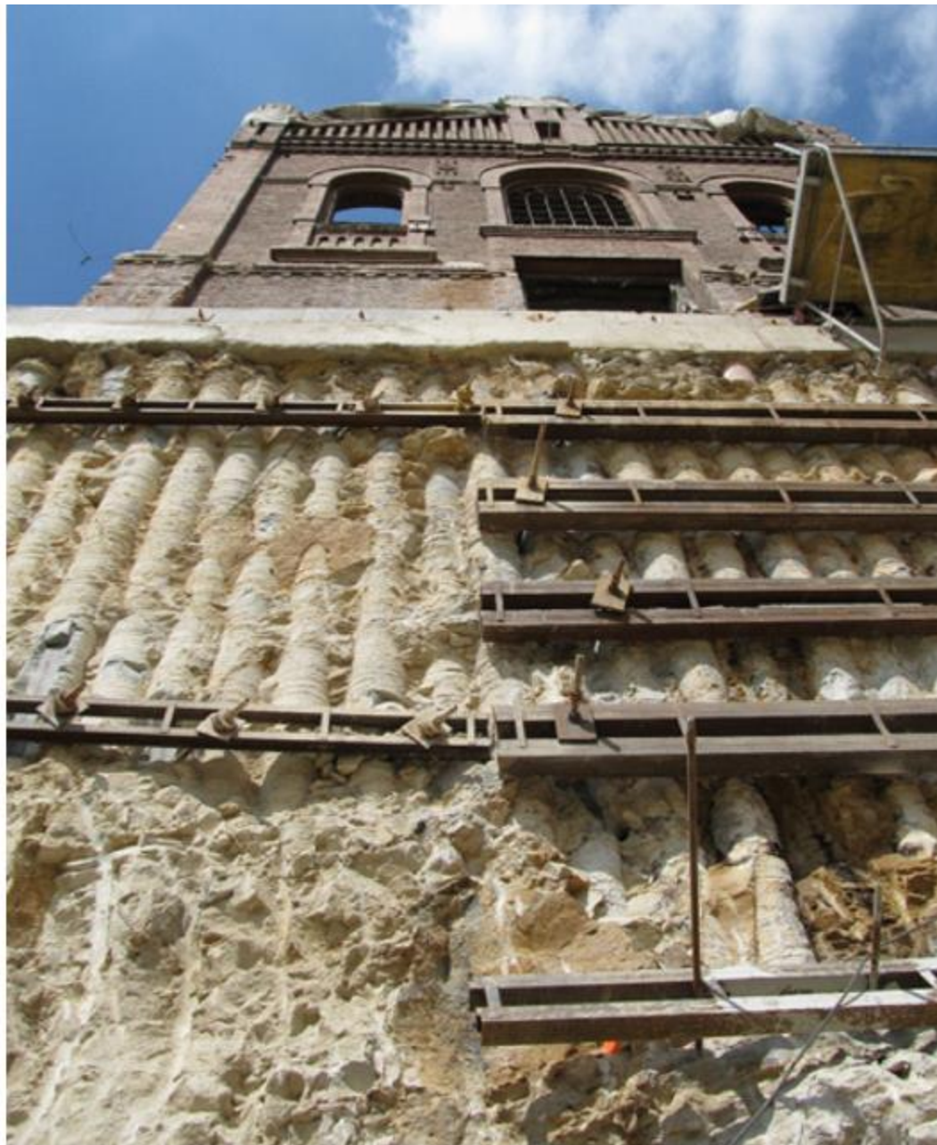
Piotr Rychlewski, Palisady jako zabezpieczenie wykopów, Inżynier Budownictwa, 04.2019
