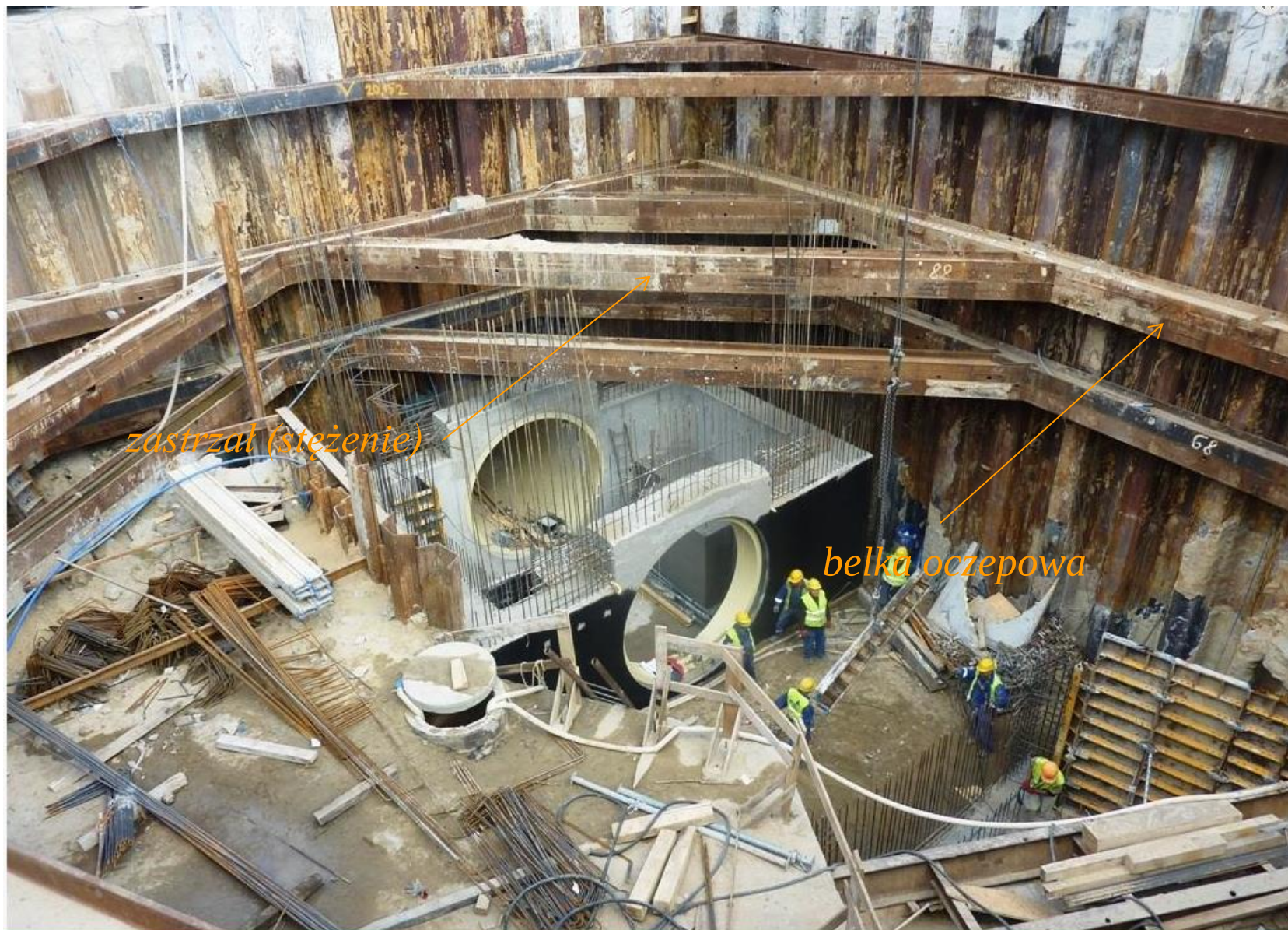
Rozparcia i stężenia wewnątrz wykopu, (budowa Kolektora Burakowskiego bis, Warszawa)
