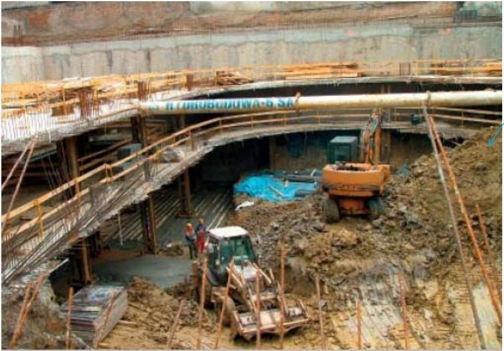
Ściany szczelinowe obudowy wykopu podparte stropami kondygnacji podziemnych
