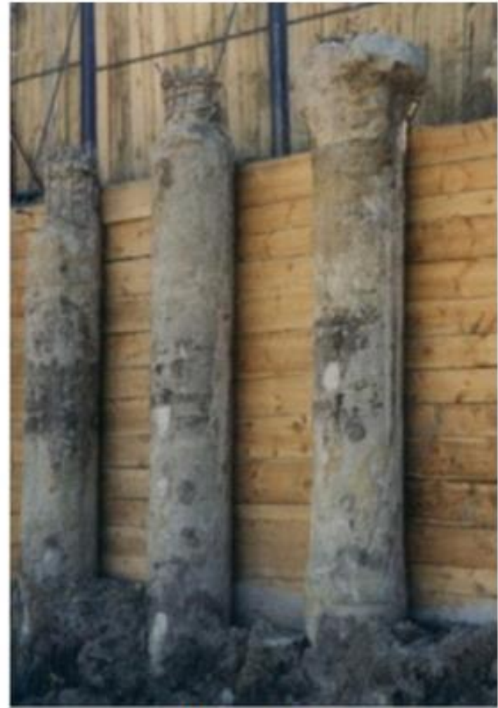
Fot. 6 Przykład palisady wykonanej z różnych elementów - pierwotne to kolumny DSM, a wtórne to pale CFA zbrojone / Fot. 7 Palisada z pali rozsuniętych, przestrzeń między palami wypełniona opinką drewnianą
